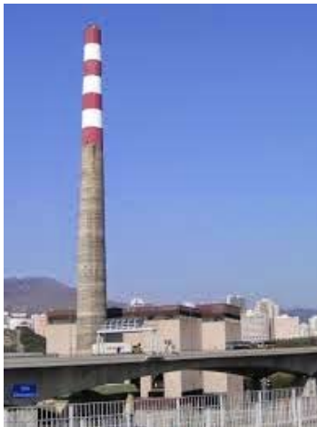
Gambar 4. Insinerator pengolahan limbah B3
