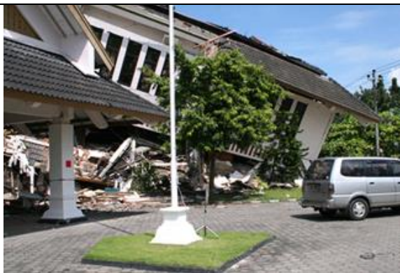
Gambar 14a Bagian barat (kanan) gedung runtuh akibat torsi dan soft column effect .
