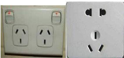
Gambar 10 Tusuk Kontak dan Kotak Kontak Jenis I.
